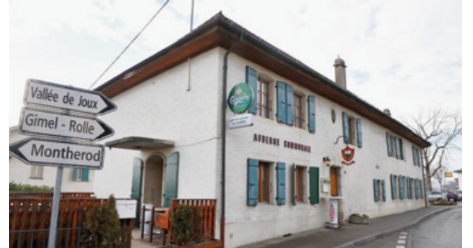
L'extérieur de l'auberge communale a besoin d'être rénové. ARCH. LA CÔTE
